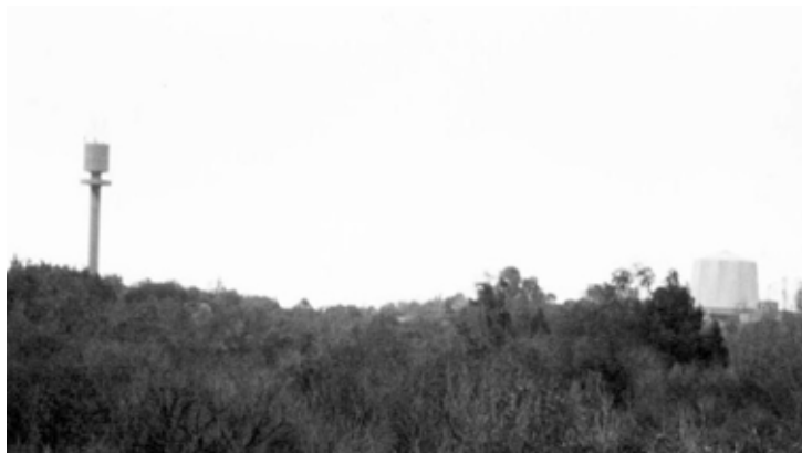
Jeg arbejdede dels på atomforsøgsstationen Soreq syd for Tel Aviv. Reaktoren t.h. og vandtårnet tv.
